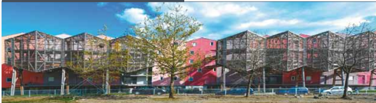
Logements « comme des maisons », ZAC Vallon des Dervallières, Nantes (44)
