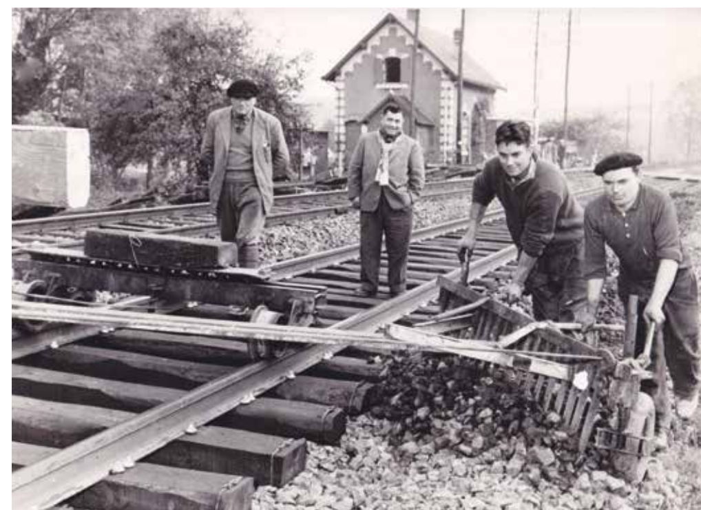
Réglage de ballast au Dodge rail-route, entreprise Vecchiotti, fin des années 1950. Photos, Sylvain Knecht.
