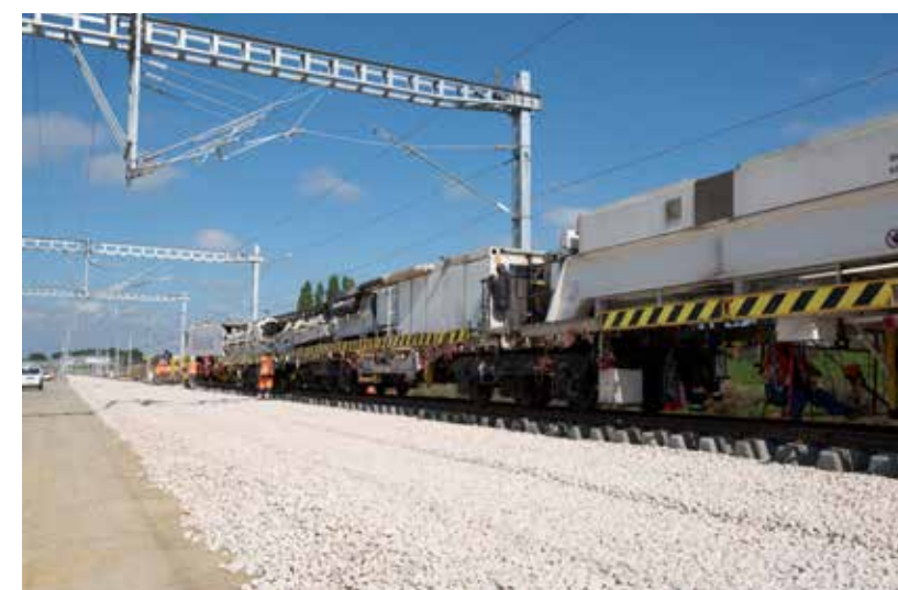
Pose des voies de la LGV Bretagne-Pays-de-la-Loire par Eiffage Rail, 2015.
