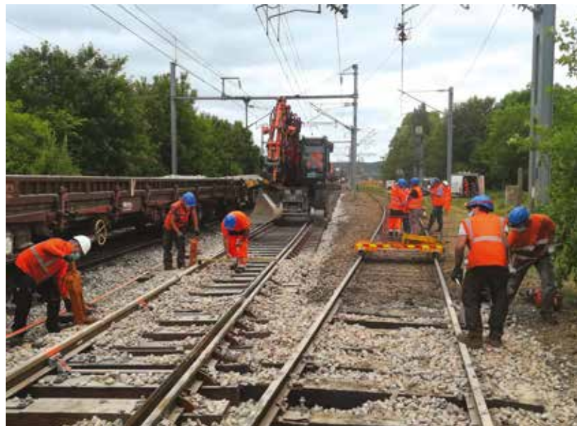
↖ Renouvellement d'appareils de voie à Serquigny (Eure) par UNIFER, 2021.
