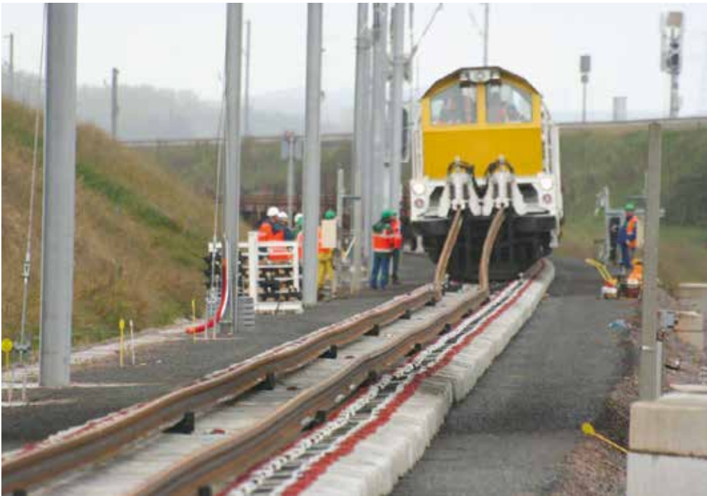
Construction de la LGV Est européenne, 2 e phase, entre Baudrecourt (Moselle) et Vendenheim (Alsace), 2014. Pose simultanée de 2 longs rails
