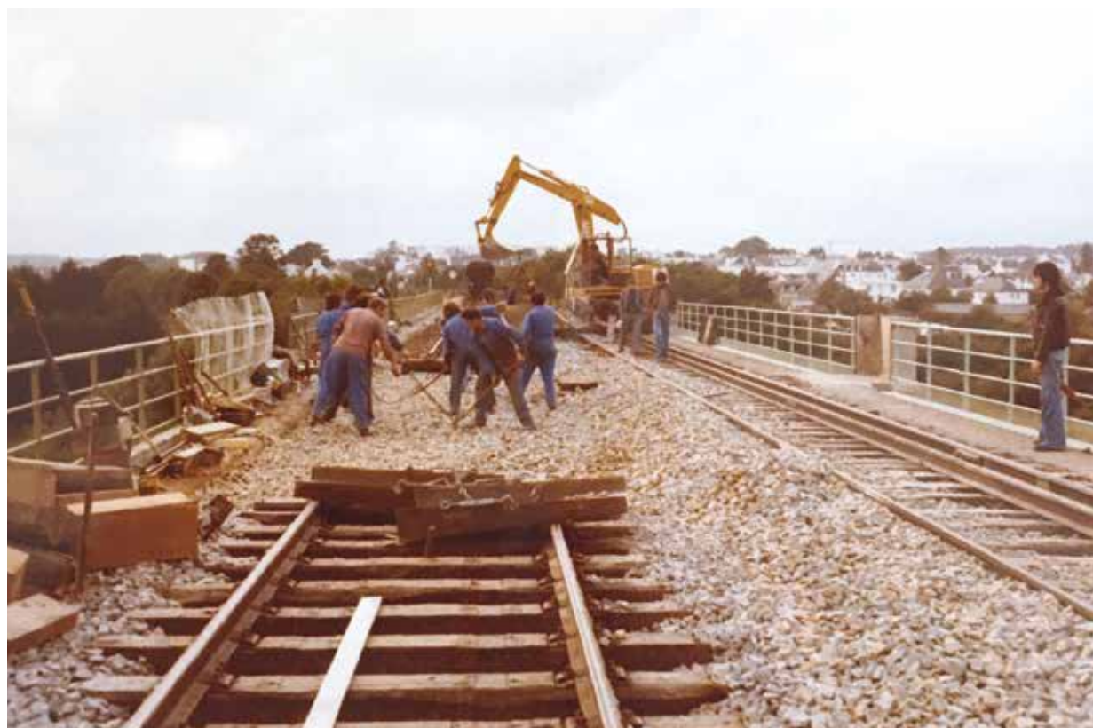
Ambiance de chantier, remplacement de voies sur un viaduc, entreprise Olichon, années 1980.
