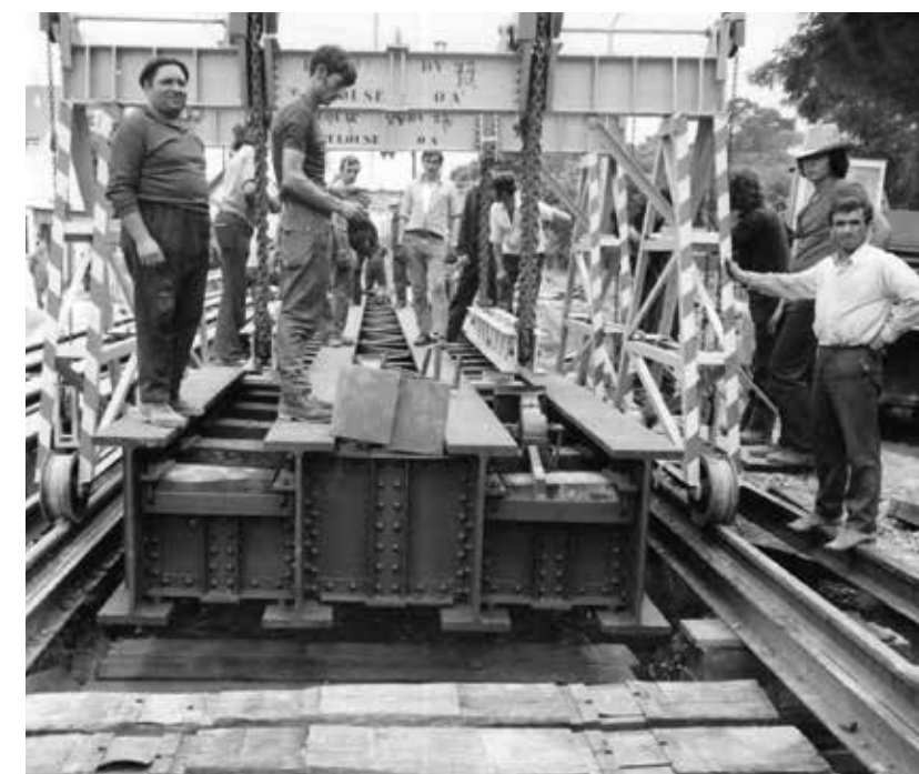
↖ Tina et Angelo Meccoli dans la cour de l'entreprise. ↗ Pose d'un tablier métallique, entreprise Meccoli.
