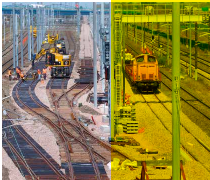
Construction d'une quatrième voie entre Vendenheim (Bas-Rhin) et Strasbourg, ici au triage de Hausbergen, 2021. Fourchard et Renard a posé les appareils de voie et s'apprête à poursuivre l'approvisionnement en ballast.
